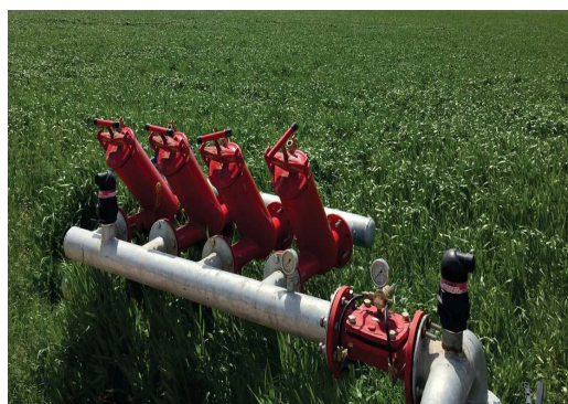
شکل 29- پایش فشار کارکرد سامانه در محل واحد آبیاری یک سامانه آبیاری قطره‌ای زیرسطحی گندم در منطقه بوئین زهرا (یوسف گمرکچی، 1398)
