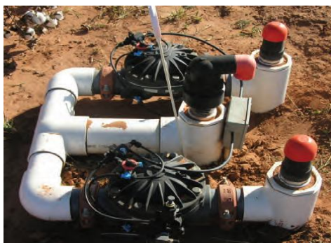
شکل 9- بکار گیری شیر خلأ شکن در سامانه آبیاری قطره‌ای زیرسطحی (منبع، بی نام)
