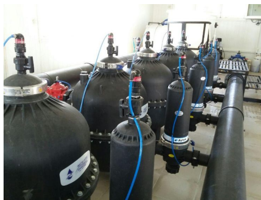
شکل 19- نمونه‌ای از یک واحد کنترل مرکزی خودکار سامانه آبیاری قطره‌ای زیرسطحی در منطقه بوئین زهرا (یوسف گمرکچی، 1398)
